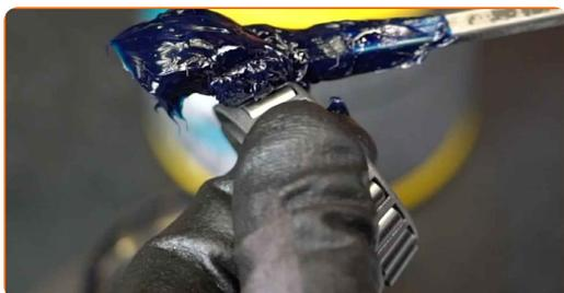
**29** Monter lagerelementene i hjulnavet.
