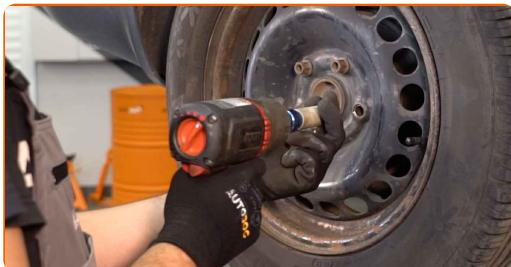
**Utskifting: bremseskiver – VW Passat B5 Stasjonsvogn (3B5). AUTODOC
